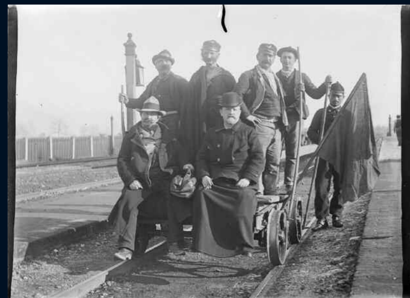
Ingegneri ferroviari verificano la posa dei binari.
